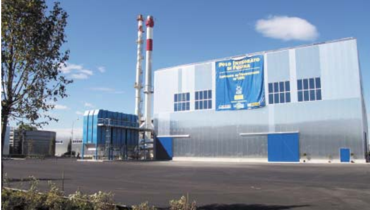
Impianto di biostabilizzazione a secco di Fusina (VE) con tecnologia Herhof-Ladurner. Tratta 197.000 tonn/annue di materiali provenienti dalla frazione secca ed organica con 2 impianti da 25 biocelle compressive e 2 sofisticati impianti per il trattamento dell'aria (LARA)
